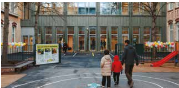
L'école Rabelais a été entièrement réhabilitée.
