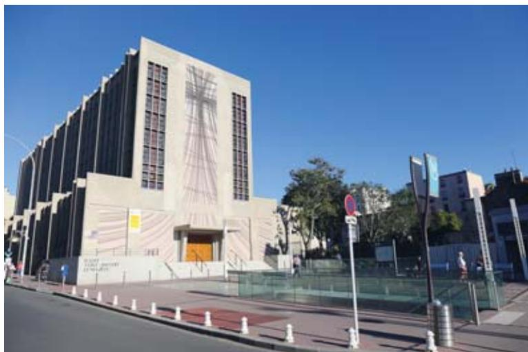
La construction ne sera pas finalisée car en raison de la guerre, le clocher et deux chapelles du plan initial ne seront jamais bâtis. En choisissant le béton armé comme matériau et la technique des portiques articulés mise au point par l'ingénieur Eugène Freyssinet (lire encadré), Éric Bagge affiche un parti pris architectural très fort. C'est le seul édifice religieux utilisant ce procédé moderne qui permet de dégager un volume
