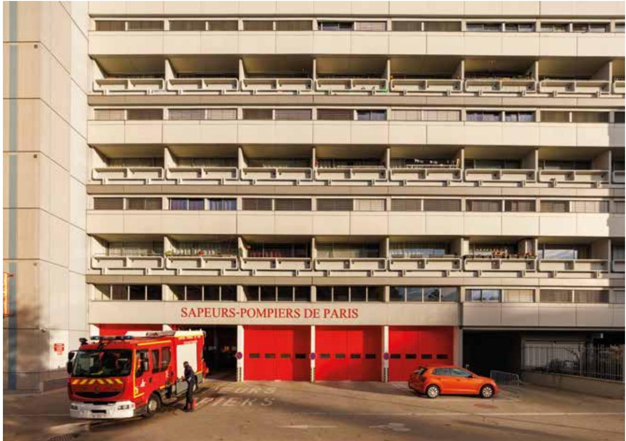
20- Les garde-corps préfabriqués sculptent la façade en béton brut de la caserne de pompiers de Montrouge, au 53 rue de la Vanne.
