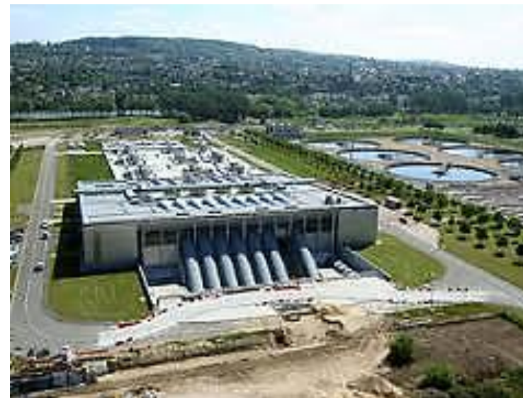
Station d'épuration Seine Aval. Source: SIAAP
