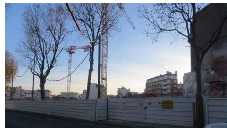
site du Crédit Agricole à l'occasion des travaux de réaménagement (Source: Even Conseil)
