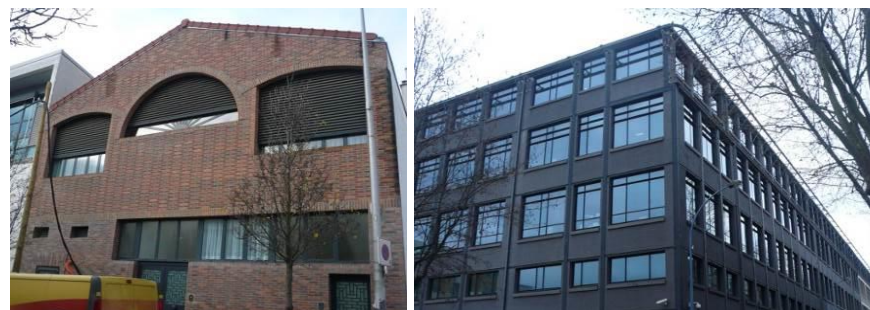
Bâtiments industriels rue Marcelin Berthelot et rue Maurice Arnoux, sources : Citadia Conseil
