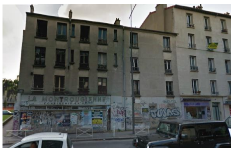
Commerces vacants sur l'avenue Pierre Brossolette – Source : Google maps
