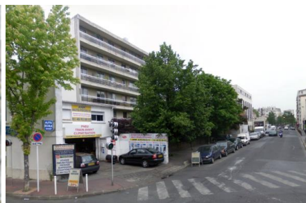
Habitations et garage vus depuis l'avenue de la Marne – source : Google maps
