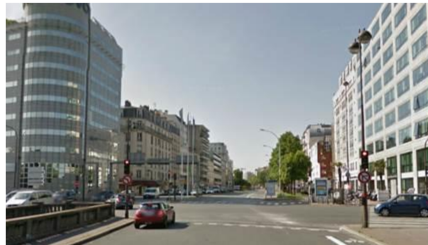
Entrée vers l'avenue Aristide Briand, source : Google
