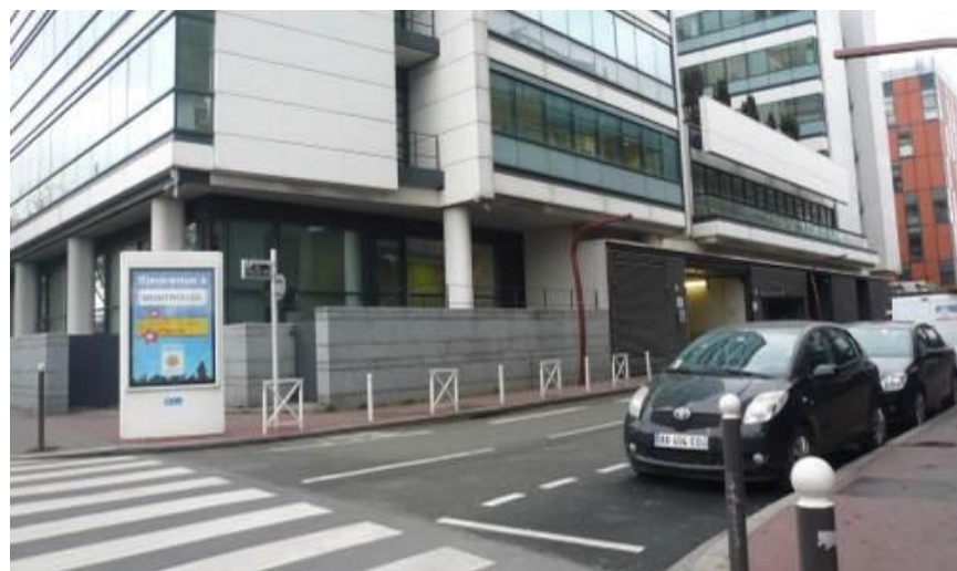
Entrée vers la rue François Ory, source : Citadia Conseil
