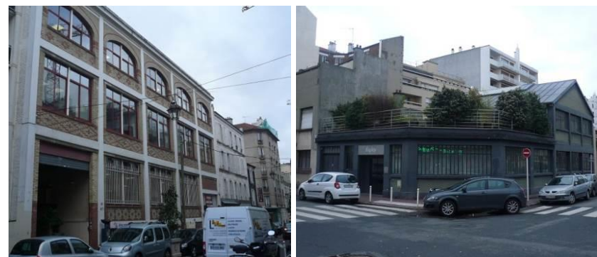
Bâtiments industriels rue Périer et rue Carvès, sources : Citadia Conseil
