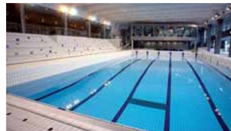
Chantier de la piscine au 24 octobre 2008.
