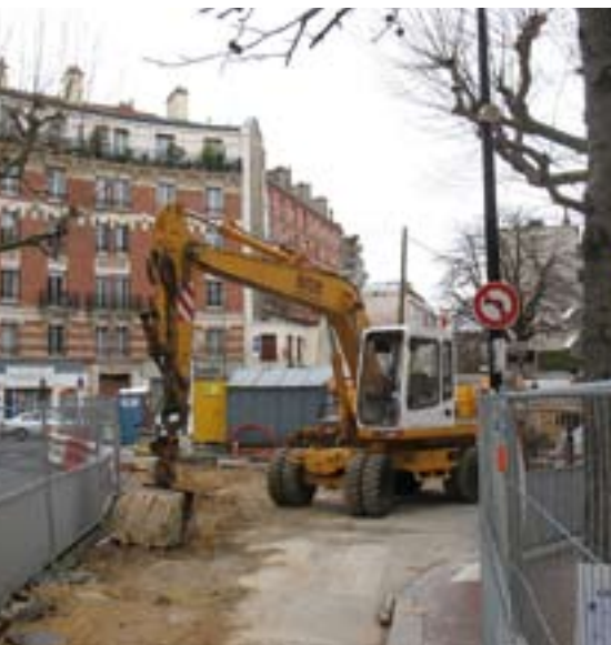
Travaux avenue Général Leclerc.
