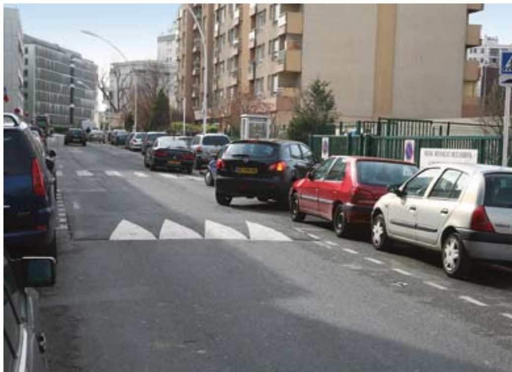
Ralentisseur installé rue de la Vanne.
