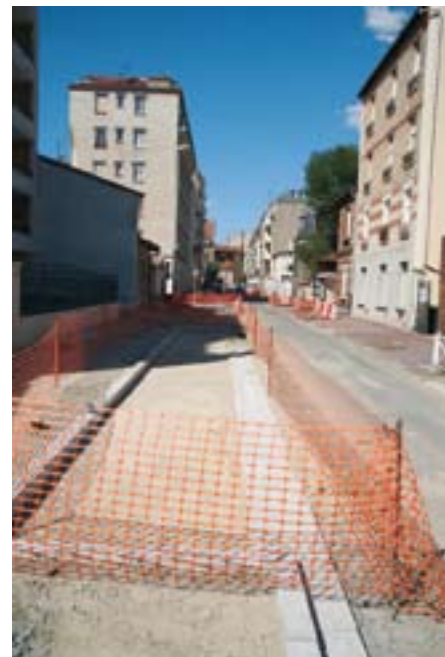
Assainissement rue Berthelot
