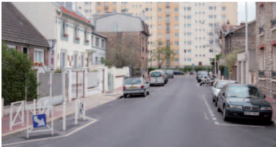
Chaussée et trottoirs refaits rue Guillot
