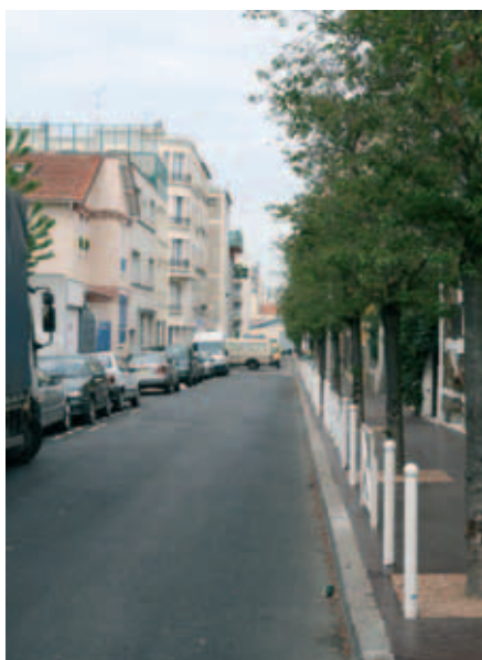
Rue Auber : Chaussée et trottoirs refaits.
