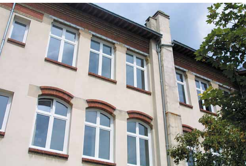
Façade de l'école élémentaire Boileau
