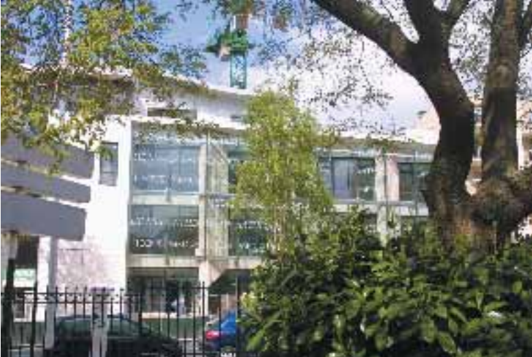
La façade de la future médiathèque est en voie d'achèvement.
