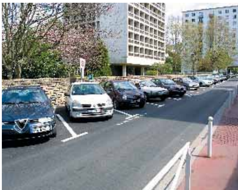
La rue Louis Pasteur après refecion de la chaussée.
